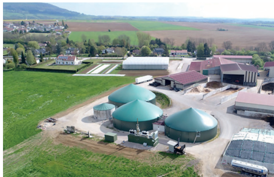
Implantation en continuité d'une implantation agricole © G3 Environnement
